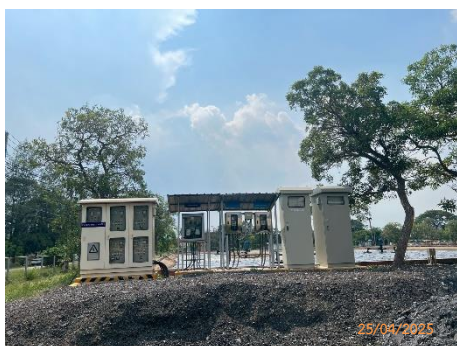
รูปที่ 2-8 อุปกรณ์ตรวจวัด COD Online บริเวณระบบบำบัดน้ำเสีย
