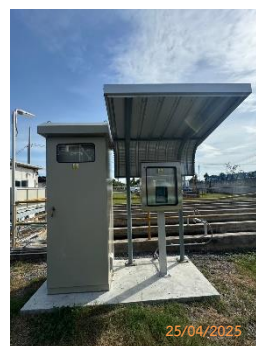
รูปที่ 2-8 อุปกรณ์ตรวจวัด COD Online บริเวณระบบบำบัดน้ำเสีย
